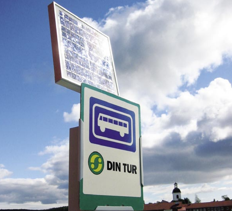
Solceller används för belysning och signalering vid hållplats.
